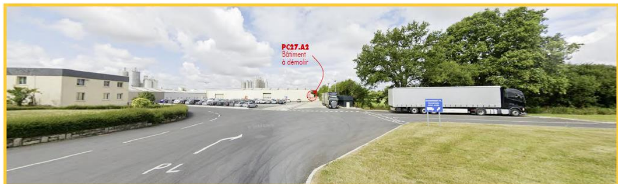
Figure 18 : Entrée du site avant travaux en 2023 (Source : Nicot Architecte)
