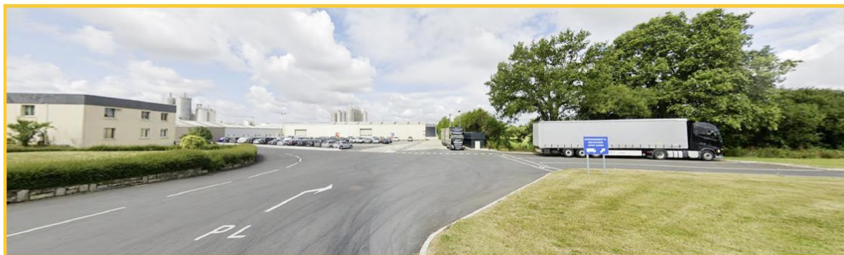
Figure 19 : Entrée du site après travaux (Source : Nicot Architecte)
